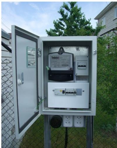
Подключение электричества к жилому дому или участку в частном секторе обычно осуществляется от опор воздушной линии электропередач (ВЛ) самонесущим изолированным кабелем с установкой счетчика в шкафу учета на фасаде постройки. Однако, для заключения договора с облэнерго недостаточно выполнить монтаж, сперва нужно получить технические условия, выполнить и согласовать проект электроснабжения. Тут то и кроются неочевидные проблемы...
